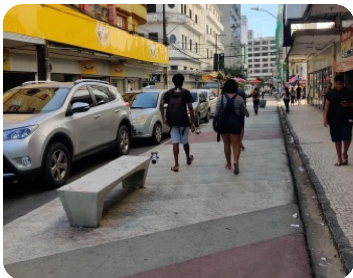
FIGURA 4 • Alargamento de calçada sobre leito carroçável na cidade de Recife-PE
